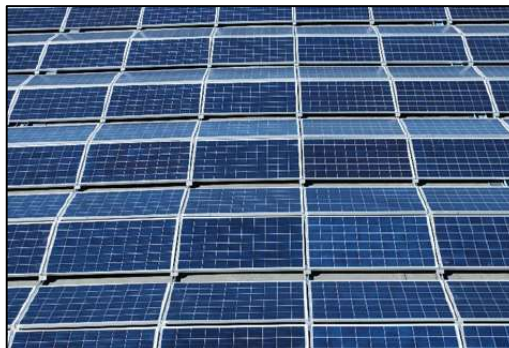
Figure 40: panneaux solaires photovoltaïques polycristallin installés sur une toiture plate
