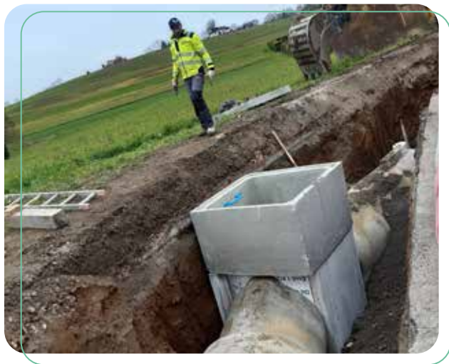
Travaux à Nâves-Parmelan - Création d'un bassin de rétention des eaux pluviales du chef-lieu et pose d'un collecteur de diamètre 1 000 mm.
