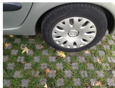
Parking en pavés béton/gazon Source : PAULHAN Magali - Idron (64)
