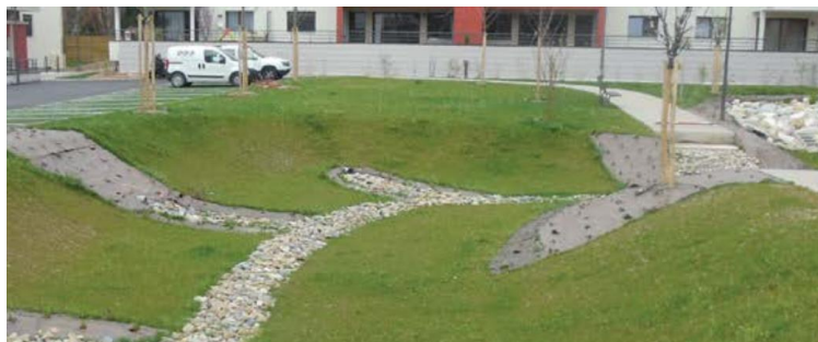
Bassin sec Source : Symasol
