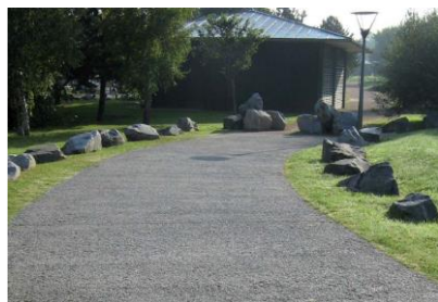
Allée en béton poreux Source : Grand Lyon
