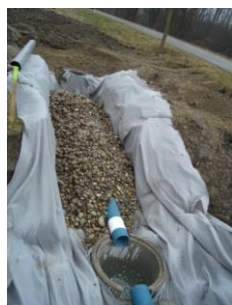
Aménagement d'une structure réservoir sous voirie
