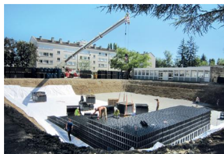
Structure réservoir alvéolaire
