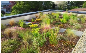
Toiture extensive composée Source : Ecovégétal
