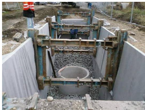
Bassin enterré en cours de réalisation
