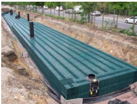
Bassin enterré à structure alvéolaire
