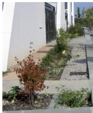
Tranchée d'infiltration avec aménagements de surface
