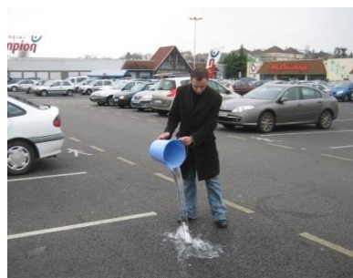
Structure réservoir sous parking avec enrobé poreux
