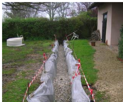
Tranchée en cours de remplissage
