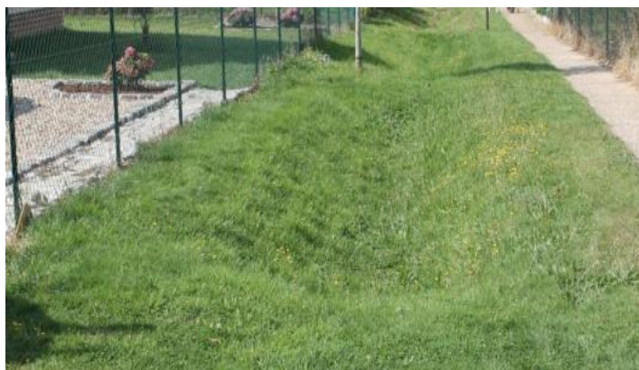
Noue en bordure d'allée Source : Alise Environnement
