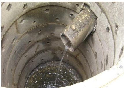
Alimentation d'un puits Source : Bourguiclic
