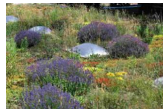
Toiture semi-extensive Source : @d aménagement durable
