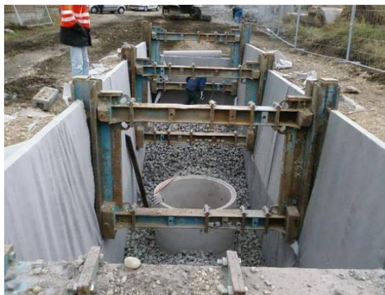
Bassin enterré en cours de réalisation
