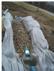
Aménagement d'une structure réservoir sous voirie Source : Samuel Lollier
