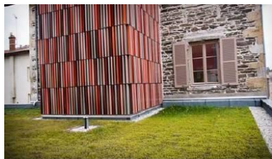
Toiture extensive simple Source : Grand Lyon
