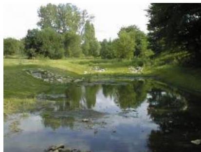
Bassin en eau
