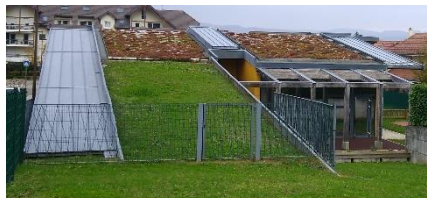
Toiture végétalisée Source : SEPIA Conseils
