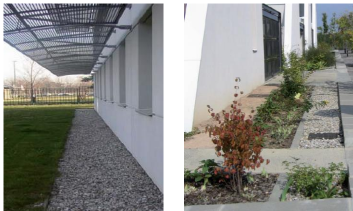
Tranchée d'infiltration avec aménagements de surface
