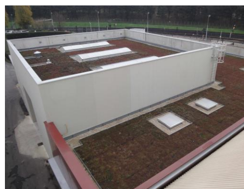
Toiture terrasse stockante
