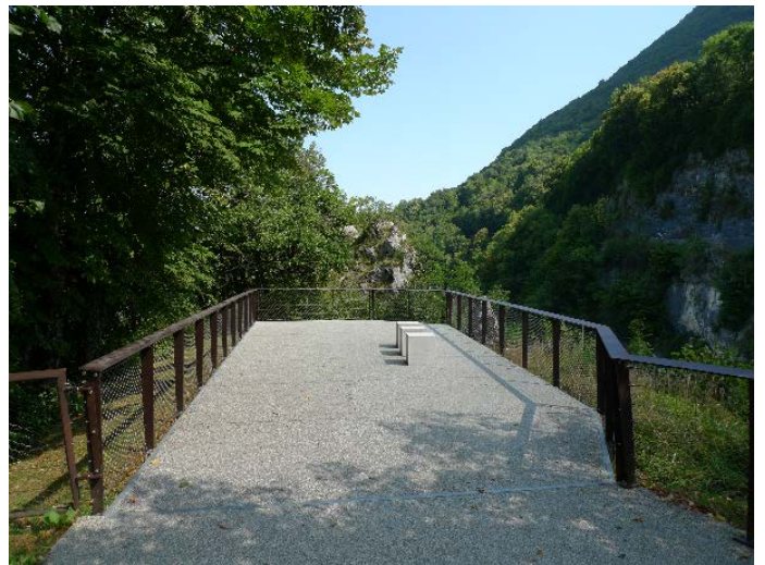
Aménagement du pont de l'Abîme, Cusy
