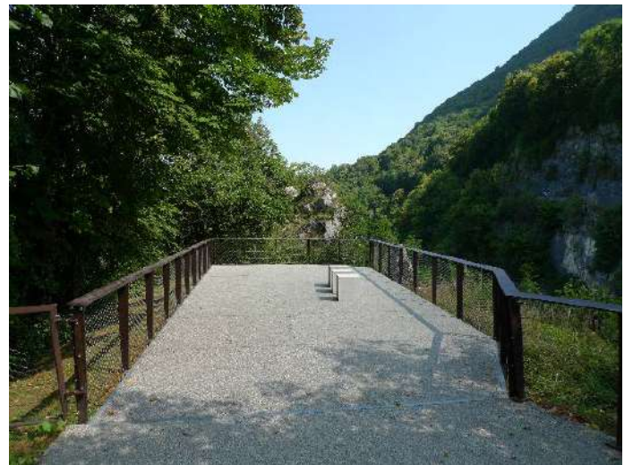
Aménagement du pont de l'Abîme, Cusy
