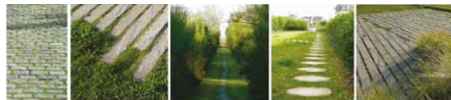
Exemple de matériaux et d'assemblages permettant la perméabilité
